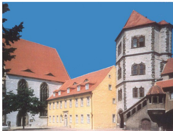
Lazarett-Gebäude auf der Moritzburg in Halle an der Saale errichtet unter Friedrich dem Großen
